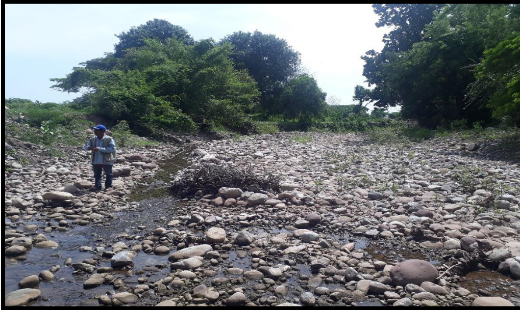
Fotografía No 21 Último tramo de agua en el cauce del río chiriaimo en el sector conocido como La Estancia justo antes del inicio de los muros de contención. (Coordenadas 1099530E, 1635405N)
