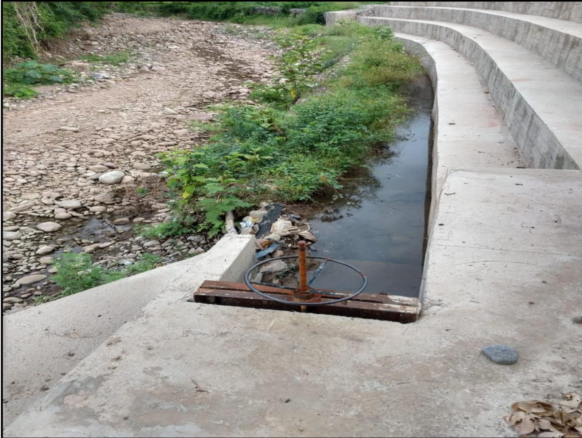
Fotografía No 23 Compuerta para canal de derivación del último tramo de agua en el cauce del río (Coordenadas 1099421.3E, 1635403.30N )
