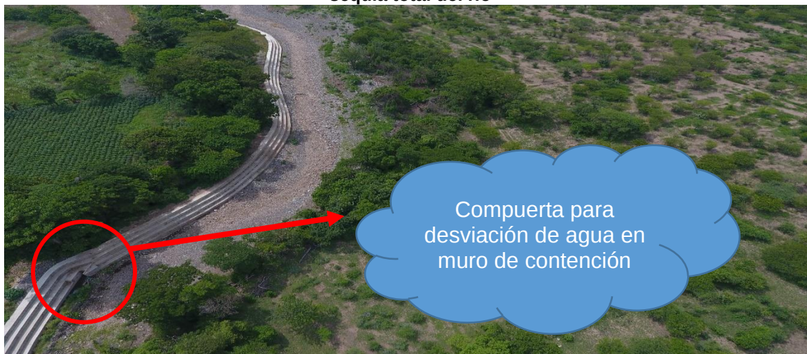
Fotografía No 22 Vuelo con Drone, evidencia de canal para desviación con compuerta y sequia total del rio
